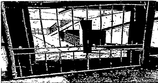
FOTO 9: Sustitución de baranda de metal
