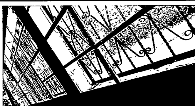
FOTO 4: Sustitución de ventanas de metal
