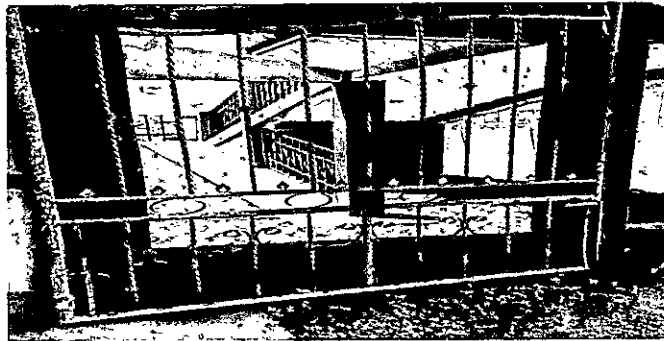
FOTO 2: Mantenimiento a portón
