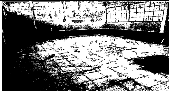
Foto 1: Sustitución de piso de concreto por piso de granito
