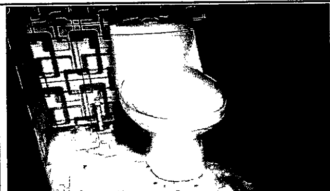
Foto 3: Sustitución de Sanitarios
