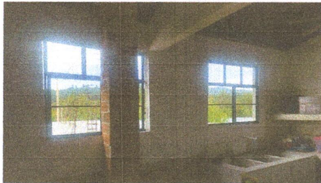
FOTO 3: Sustitución de ventanas
