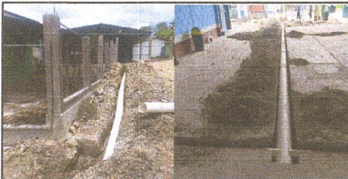
FOTO 5: Reparación de drenaje
