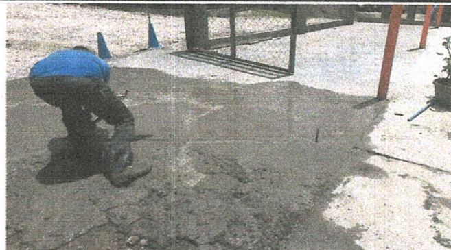
FOTO 2: Reparación de losa de patio
