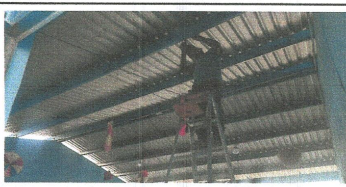
FOTO 6: Mejoramiento de sistema eléctrico
