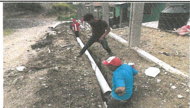
FOTO 5: Reparación de drenaje
