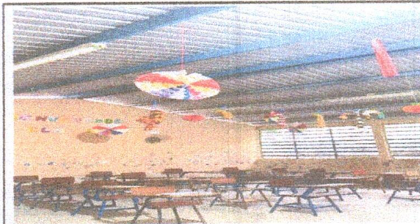
FOTO 6: Mejoramiento de sistema eléctrico
