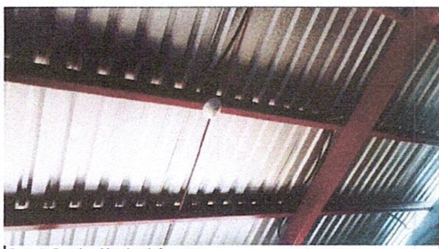
Foto 5: Sustitución de plafoneras
