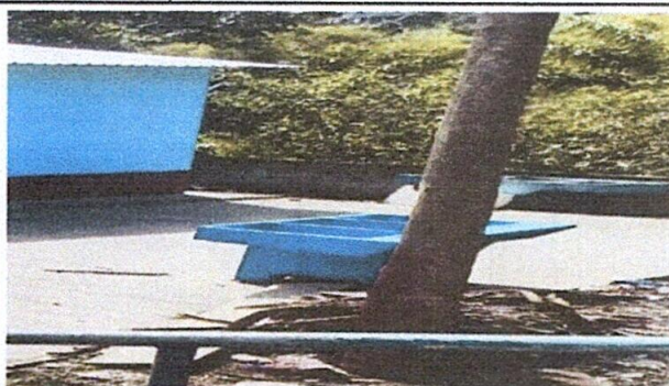
Foto 8: Sustitución de pila
