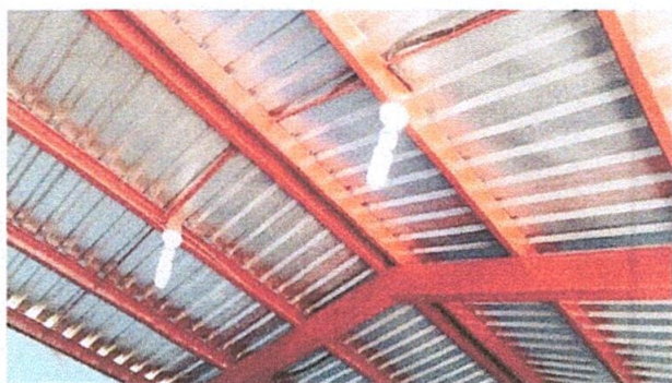
Foto 9: Sustitución de lamparas
