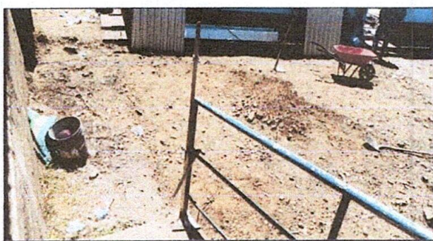
Foto 5: Planeación de superficie para la colocación de cemento en torta frente de la cocina
