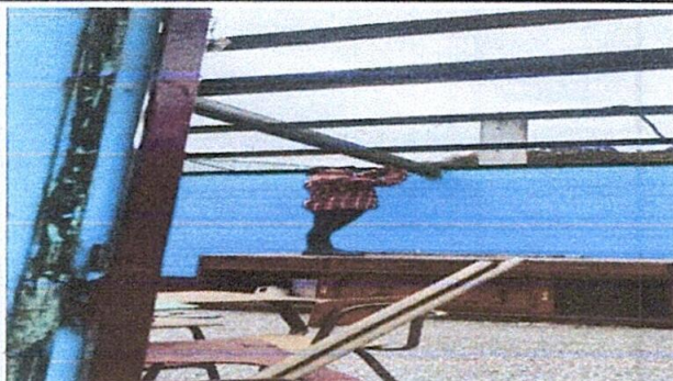
Foto 1: Lijada de costaneras de la cocina
