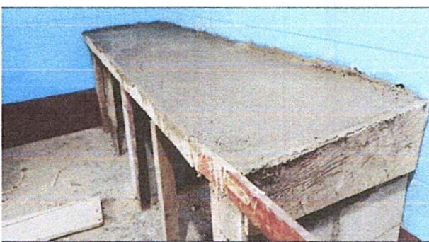
Foto 6: sustitución de mesa de concreto
