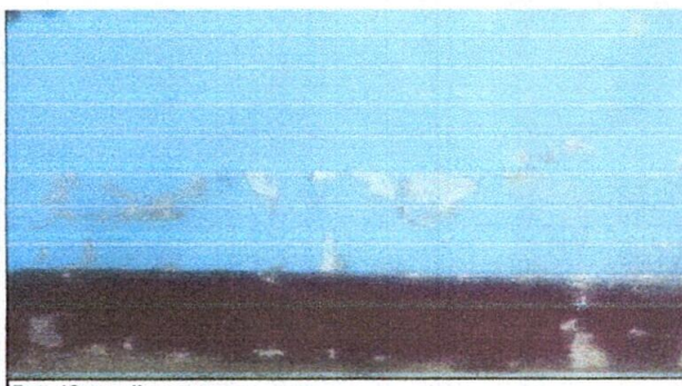
Foto 12: repello en muro
