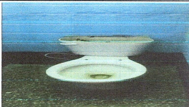
Foto 8: sustitución de inodoro
