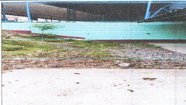
Foto 1: sustitucion de torta de concreto en frete de las aulas
