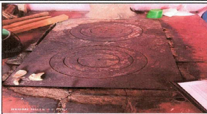
SUSTITUCIÓN DE PLANCHAS DE METAL REFORZADA
