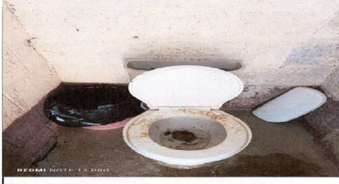
SUSTITUCION DE SANITARIOS Y AZULEJO EN PAREDES Y PISO ANTIDESLIZANTE
