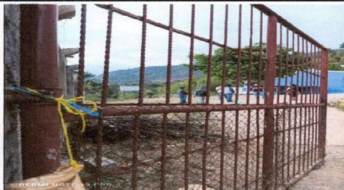
SUSTITUCION DE PORTÓN
