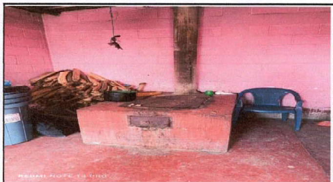
REPARACION DE CHIMENEA DE COCNETO Y MEJORAMIENTO DE ESTUFA RURAL
