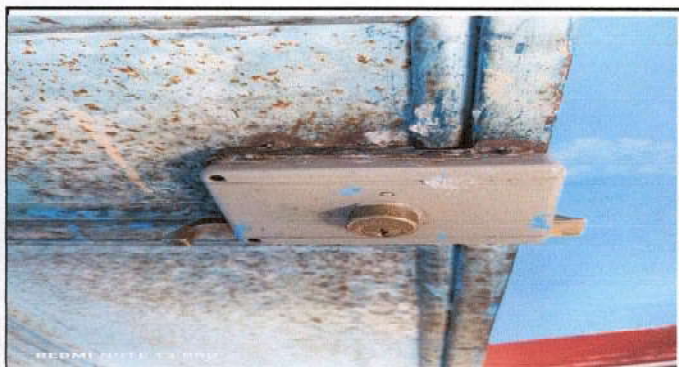
SUSTITUCIÓN DE CHAPA
