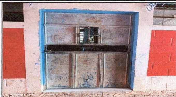
SUSTITUCIÓN DE CHAPAS
