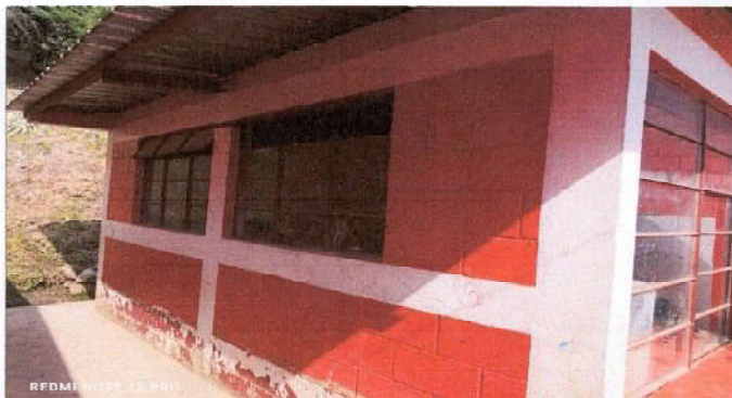
PINTURA EN MUROS EXTERIORES E INTERIORES
