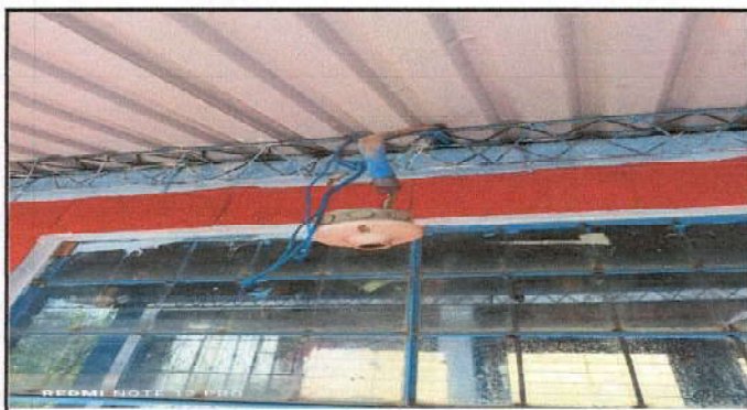
SUSTITUCION DE PLAFONERAS
