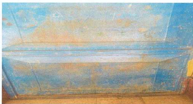
SUSTITUCIÓN DE PUERTAS DE METAL
