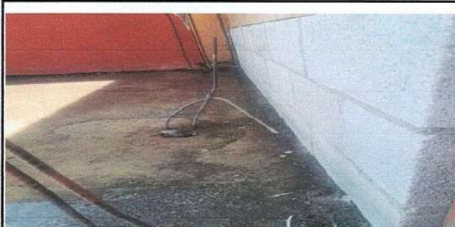
MEJORAMIENTO DE LOSA DE PATIO
