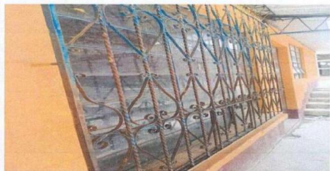
SUSTITUCIÓN DE BALCONES
