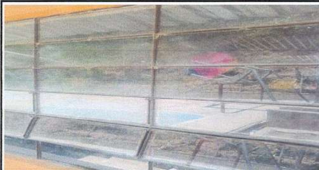
SUSTITUCIÓN DE VIDRIOS DE VENTANAS
