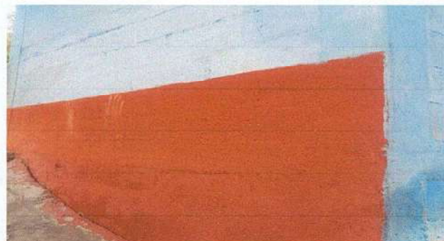
APLICACIÓN DE PINTURA EN MUROS
