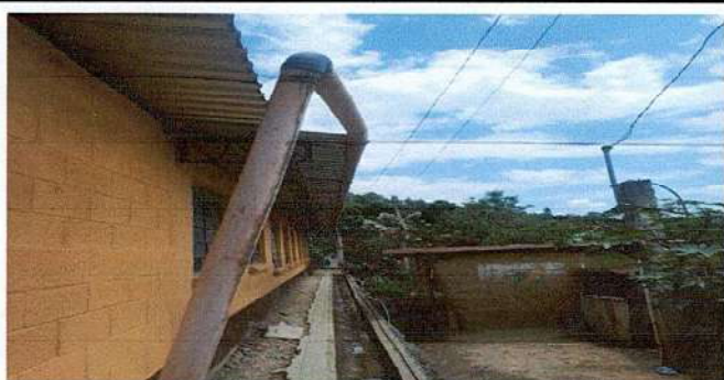
SUSTITUCIÓN DE BAJADAS DE AGUA
