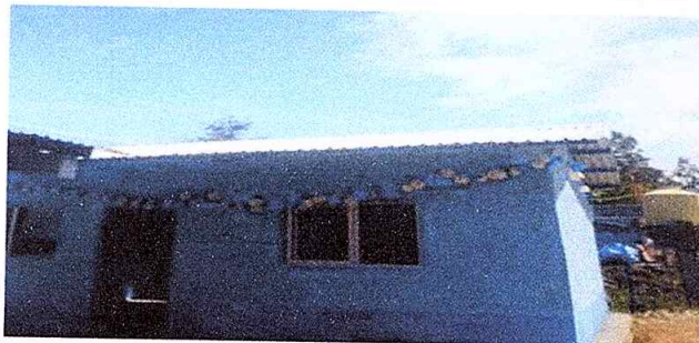
Foto 1: Sustitución de lámina, por lámina troquelada aluzinc.
