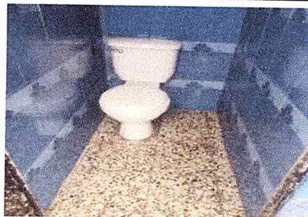
Foto 6: Sustitución de inodoro
