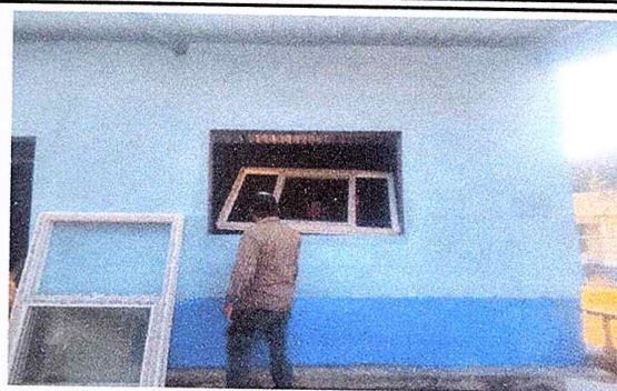
Foto 2: Colocación de ventanas.
