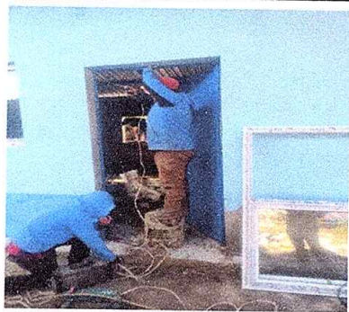
Foto 3: Colocación de la puerta metal
