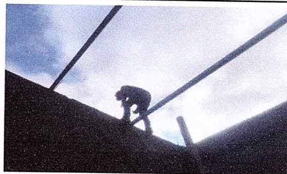
Foto 4: Colocación de Costanera
