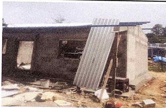
Foto1: Colocación de láminas.
