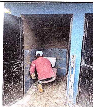
Foto 6: Colocación de inodoro
