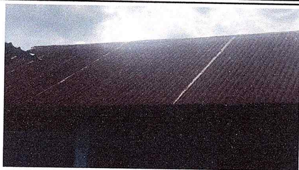
Foto 1: Sustrucción de lámina, por lámina troquelada aluzinc.
