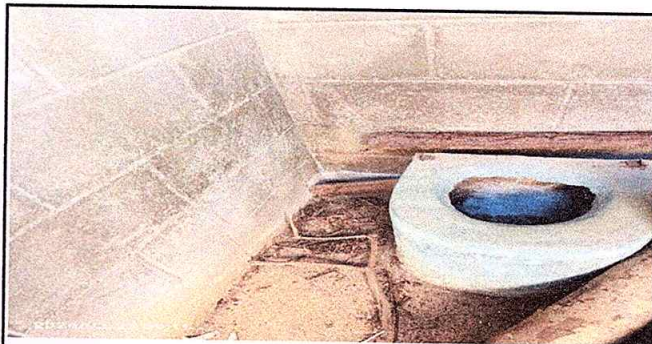
Foto 6: Sustrucción de inodoro
