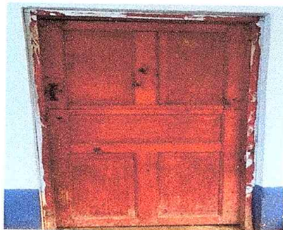
Foto 3: Sustrucción de puerta de madera a metal
