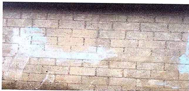
Foto 5: Pintura en muros
