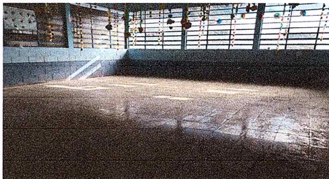
Foto 4: Mejoramiento con piso de granito
