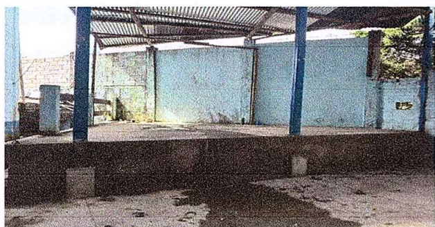
Foto 5: Repello en muro
