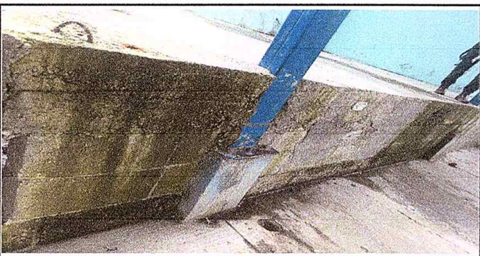
Foto 5: Repello en muro
