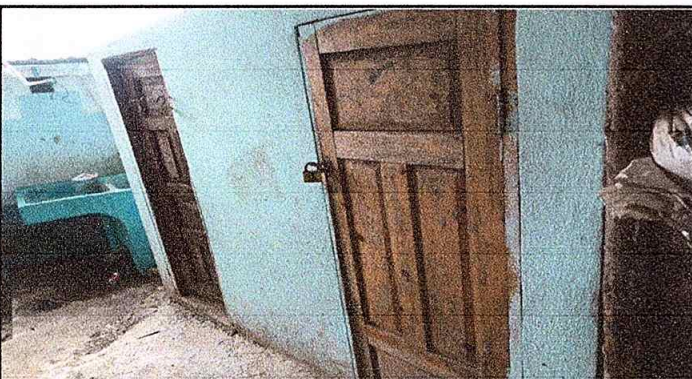
Foto 3: Sustrucción de puerta en servicios sanitarios
