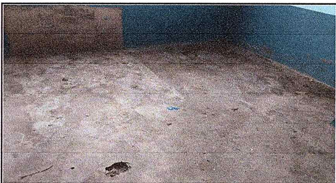
Foto 4: Mejoramiento con piso de granito
