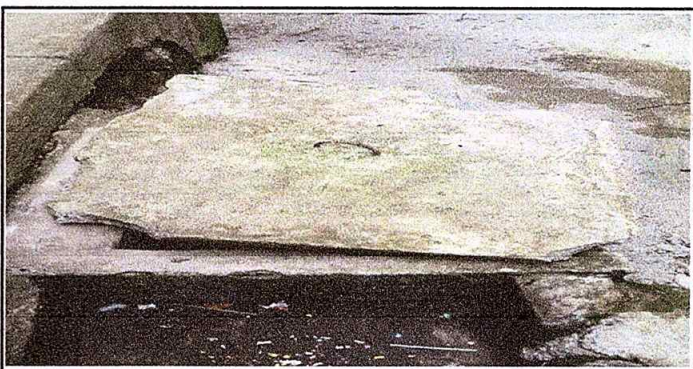
Foto 6: Mantenimiento a caja de registro
