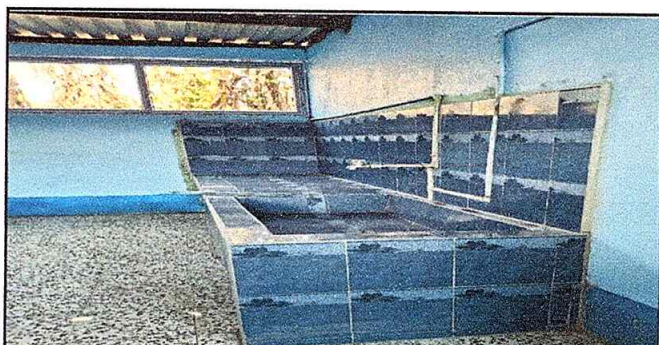
Foto 6: Colocación de azulejo a la mesa de concreto de la cocina.
