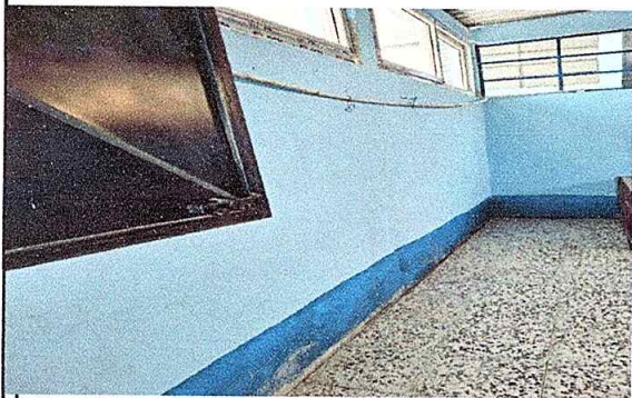
Foto 3: Colocación de pintura de los paredes de la cocina
