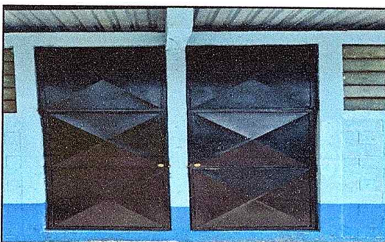
Foto 5: Colocación de puertas en el salón
