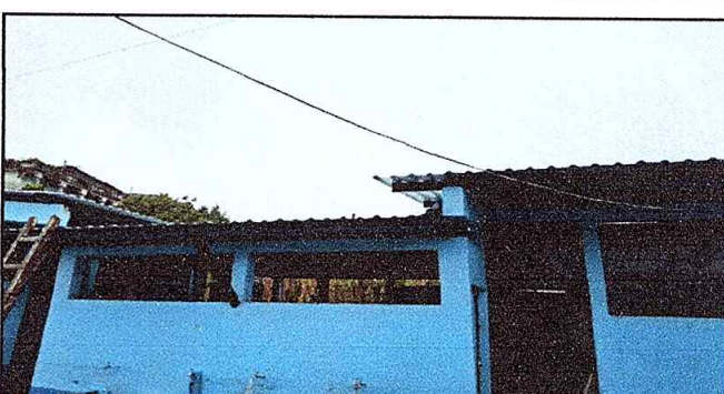
Foto 4: Colocación de ventanas corredizas para la cocina.
