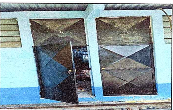
Foto 5: Colocación de puertas en el salón
