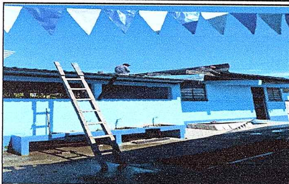
Foto1: Instalación de láminas troqueladas del salón y dirección.
