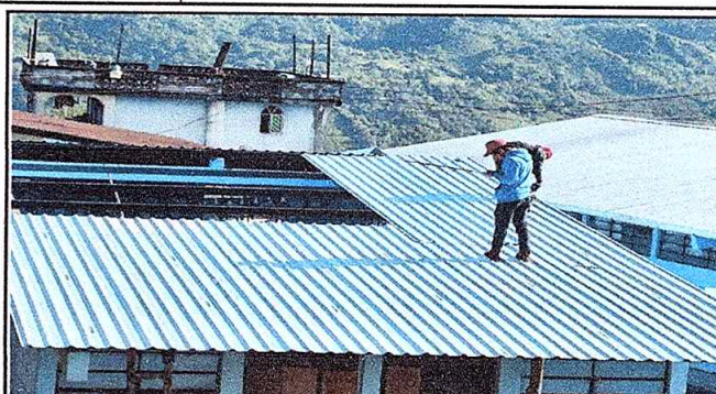
Foto 2: Sustitución de láminas a láminas troqueladas de la cocina.
