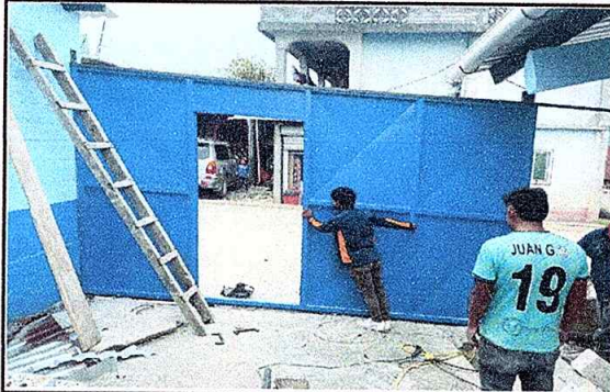
Foto 7: Colocación de Portón en la entrada principal .
