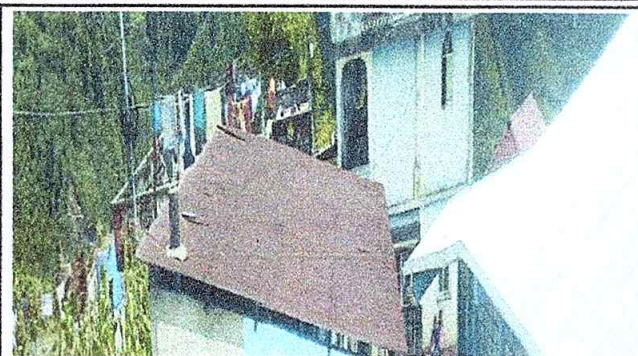
Foto 2: Sustrucción de láminas a láminas troqueladas de la cocina.
