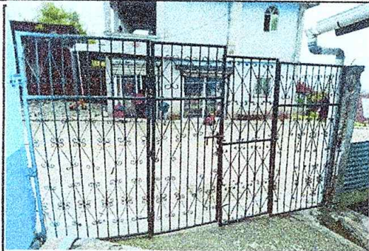
07. Sustitución de porton principal
