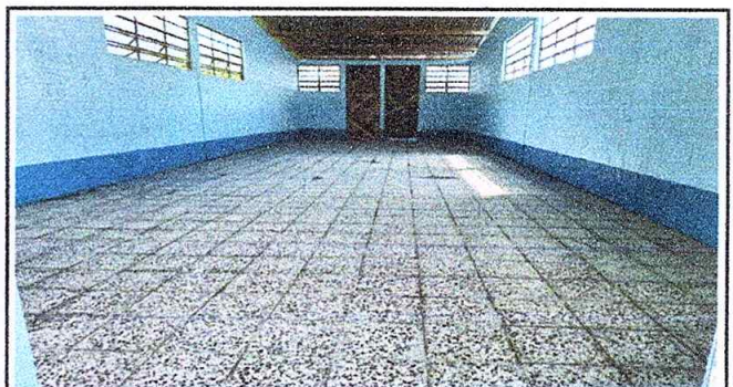
Foto 6: Sustitucion de piso de losa a piso de granito.
