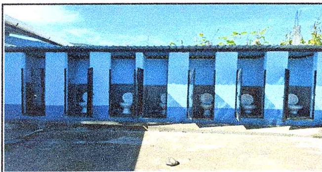
Foto 5: Inodoro colocado en su lugar.
