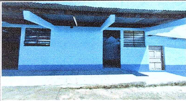
Foto1: Reparación de puertas.
