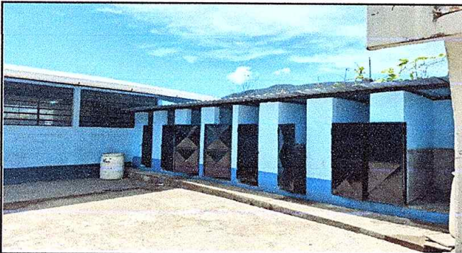
Techo de baños terminado
