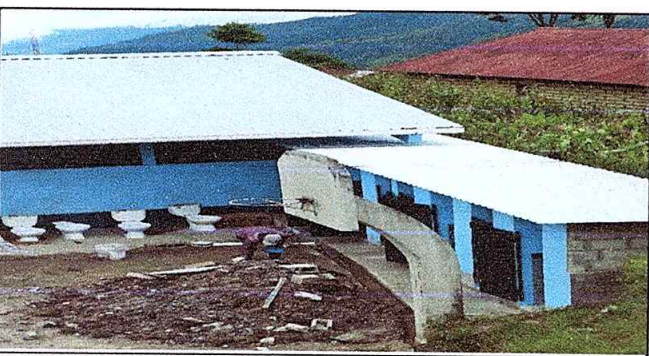
Foto 5: Colocación de inodoro.
