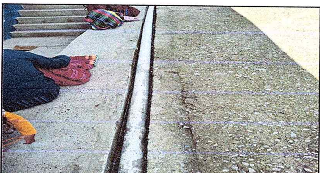
Foto 4: Reparación de cuneta.
