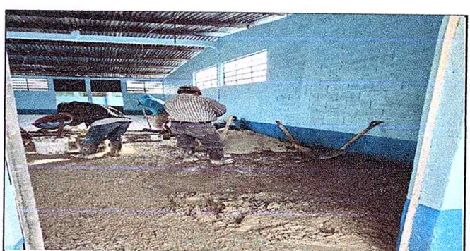
Foto 6: Colocación de piso de losa.
