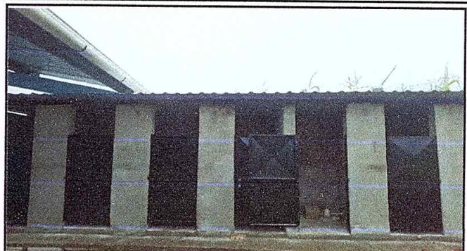
Foto 2: Repello de los baños terminado .
