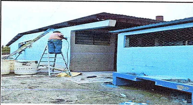
Foto 3: Colocación de pintura de los paredes
