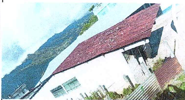
Foto 3: sustitución de lamina de baños
