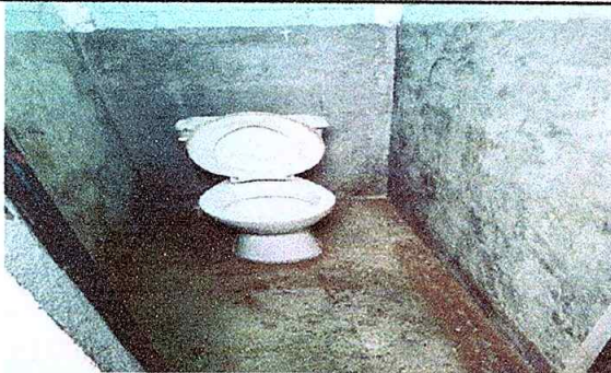
Foto 5: Reparación de inodoro.
