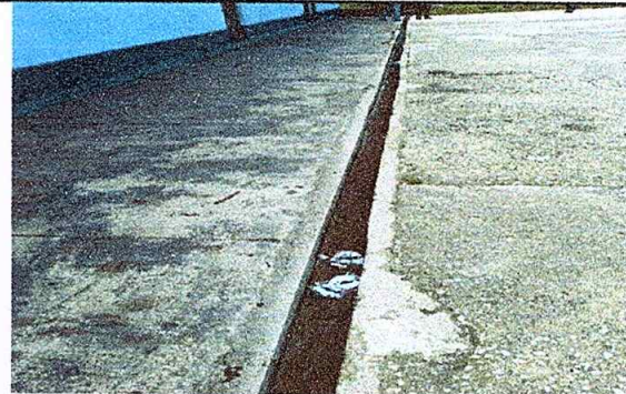
Foto 4: Reparación de cuneta.
