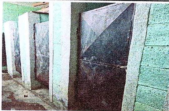
Foto 1: Sustitución de puertas.
