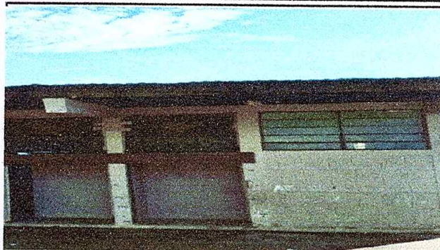
Foto 2: Sustitución de lámina
