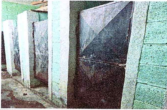
Foto 1: Reparación de puertas.
