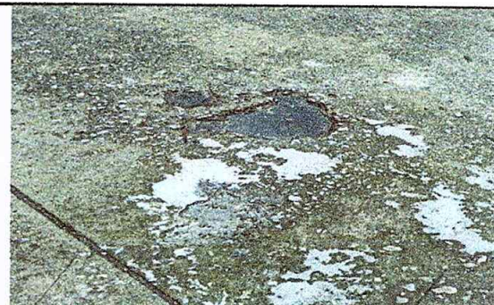
Foto 6: Reparación de piso.
