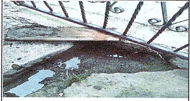
Foto 2: Reparación de drenaje.
