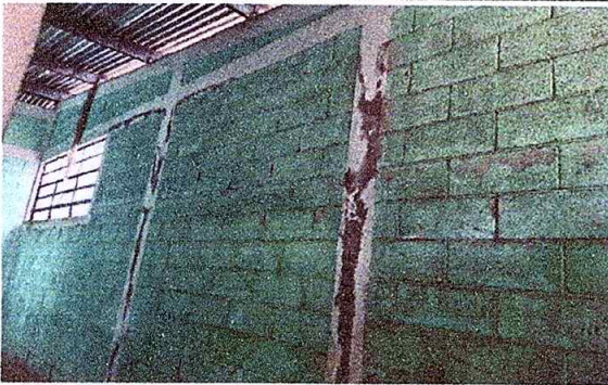
Foto 3: Reparación de pinturas.
