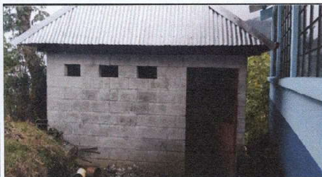
Foto 3: Exterior de la cocina que todavia le hace falta repello,
