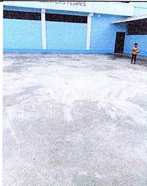
Foto 3: Reparación de planchas de concreto de patio
