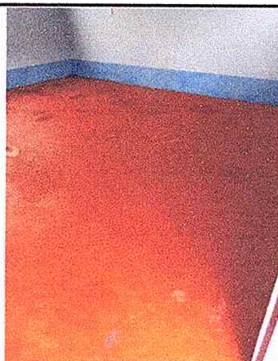
Foto 5: Sustitución de piso de torta de concreto
