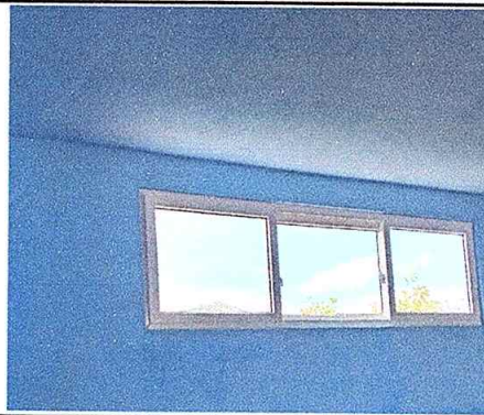
Foto 2: Sustitución de estructura de metal de ventana
