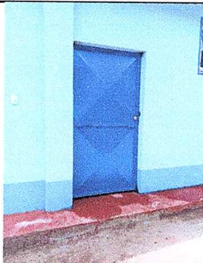
Foto 1: sustitución de puertas de cocina
