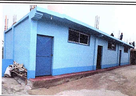
Foto8 :Pintura en muros exteriores e interiores de la cocina
