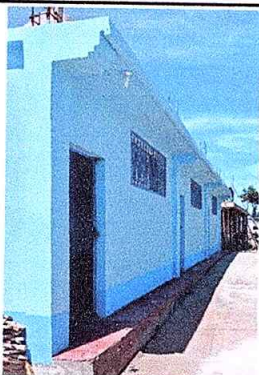
Foto7: Repello en muro interno y externo de la cocina
