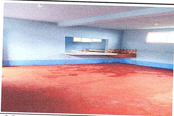
Foto 5: Sustitución de piso de torta de concreto
