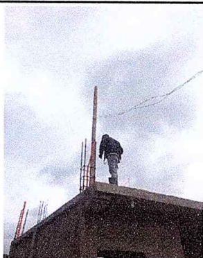
Foto9: Reparación de cableado eléctrico
