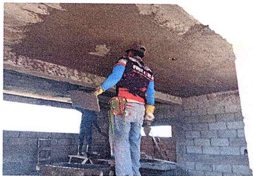
Foto7: Repello en muro interno y externo de la cocina
