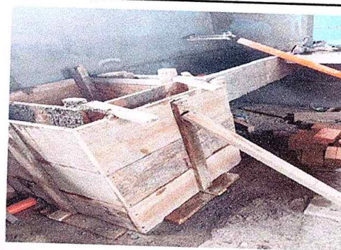
Foto 6: Sustitución de pila de cemento de dos lavadero 3m*60 cm
