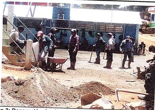
Foto 3: Reparación de planchas de concreto de patio
