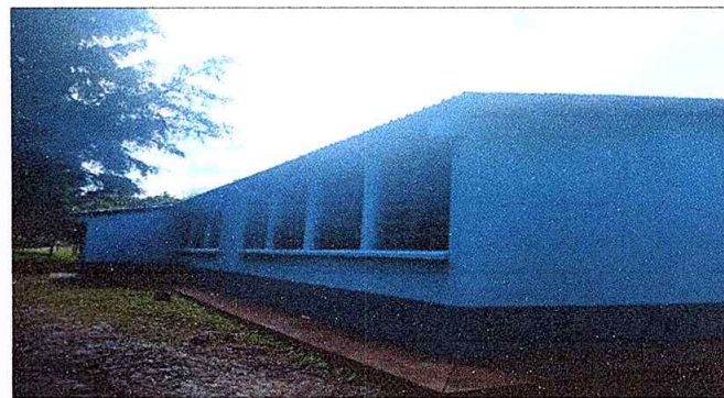
Foto 4: Pintura en muros interiores y exteriores
