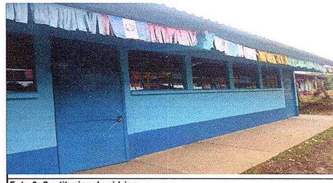
Foto 6: Sustitucion de vidrios
