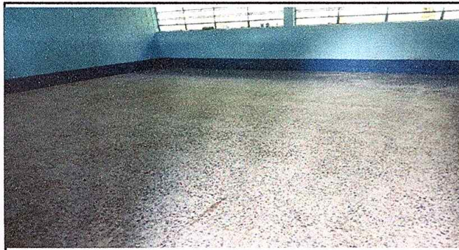
Foto1: Sustitucion de piso de cemento por piso de granito
