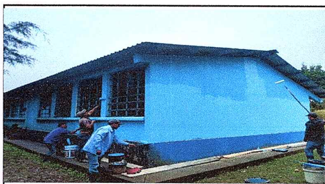
Foto 4: Pintura en muros interiores y exteriores
