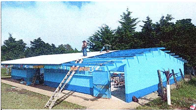
Foto 3: Sustitucion de lamian por lamina troquelada aluzinc calibre 26
