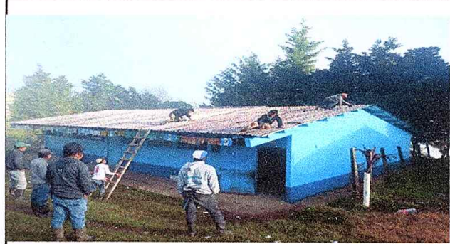
Foto 2: Sustitucion de lamian por lamina troquelada aluzinc calibre 26
