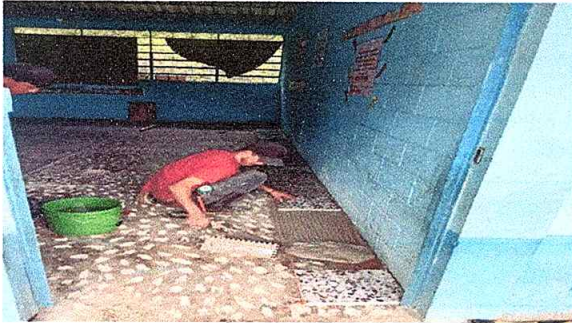
Foto1: Sustitucion de piso de cemento por piso de granito
