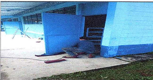
Foto 5: Mantenimiento de puertas sepillado, lijado y pintdo
