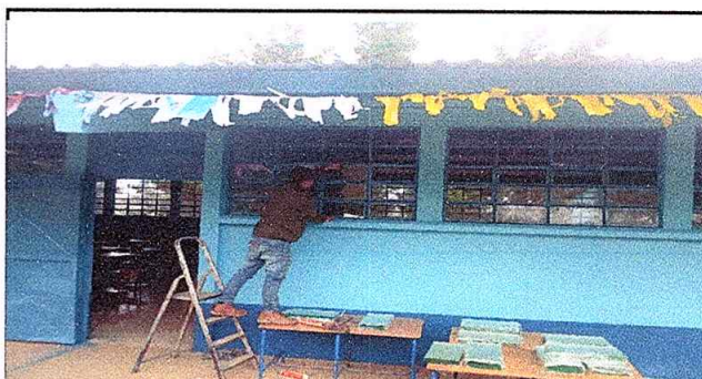
Foto 6: Sustitucion de vidrios
