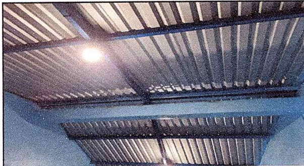
Foto 1: Sustitución de lámina troquelada y estructura portante
