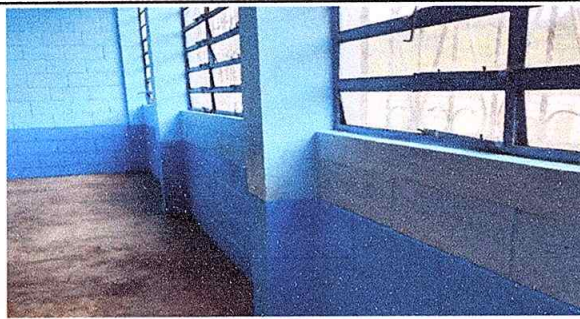
Foto 3: Sustitución de vidrios en las ventanas
