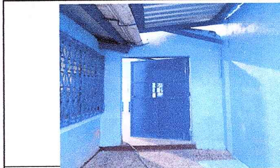
Foto 2: Mantenimiento de puertas de metal
