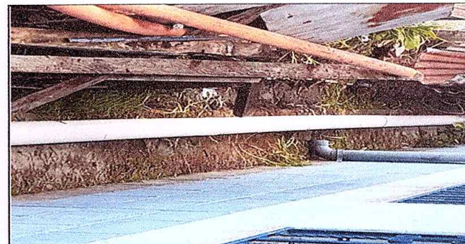
Foto 6: Sustitucion de tuberia de pvc de 4 pulgadas
