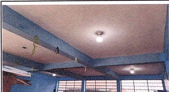
Foto1: Sustitucion de focos ahorradoras
