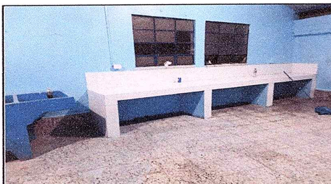
Foto 3: Mesa de concreto para la cocina
