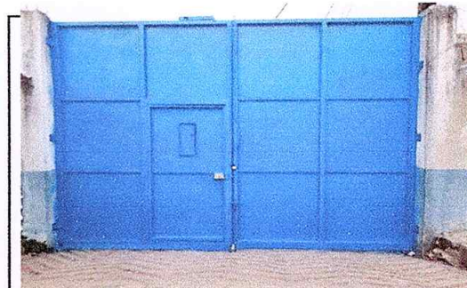
Foto 6: Mantenimiento de portón de metal
