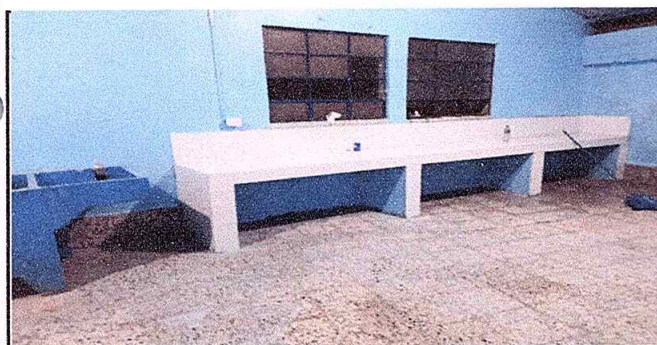
Foto 5: Colocacion de azulejos en muebles de cocina
