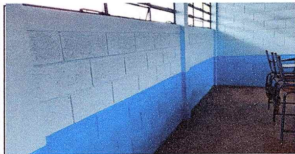
Foto 5: Pintura en muros interiores
