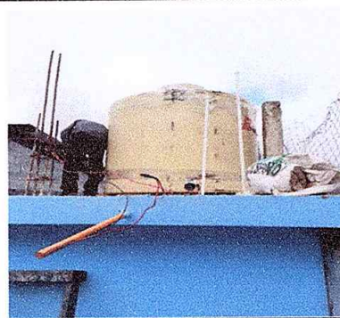
Foto 2: Sustitucion de deposito de agua de 2500 litros
