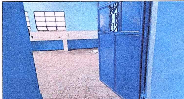
Foto 4: Sustitución de piso de granito
