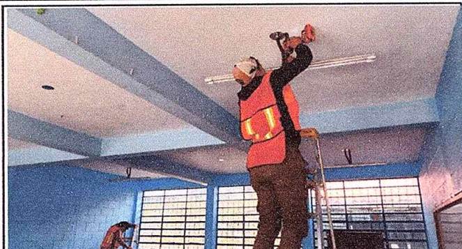
Foto 1: Sustitución de focos ahorradoras
