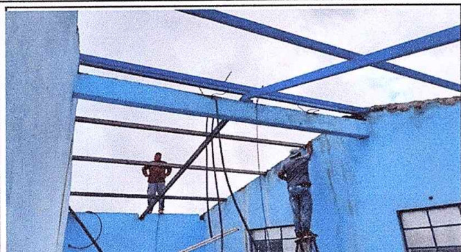
Foto 1: Sustitución de lámina troquelada y estructura portante
