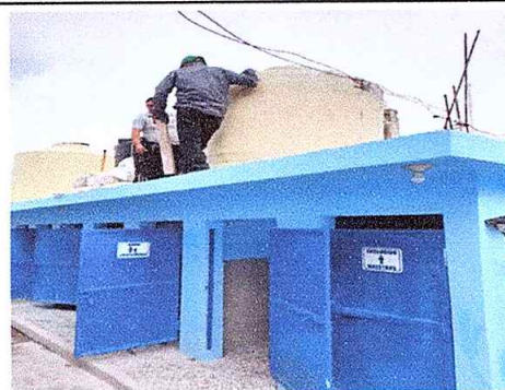
Foto 2: Sustitución de depósito de agua de 2500 litros
