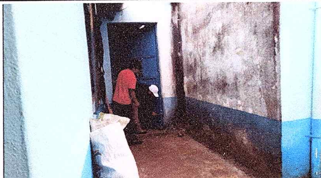
Foto 2: Mantenimiento de puertas de metal
