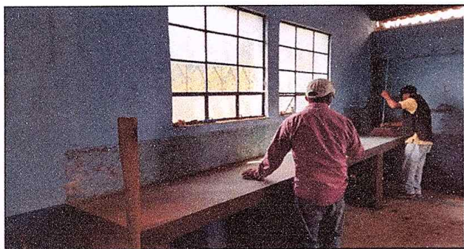
Foto 5: Colocación de azulejos en muebles de cocina
