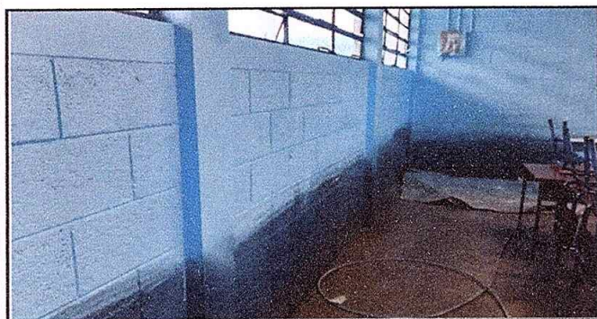
Foto 5: Pintura en muros interiores
