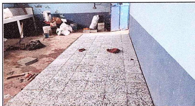
Foto 4: Sustitución de piso de granito
