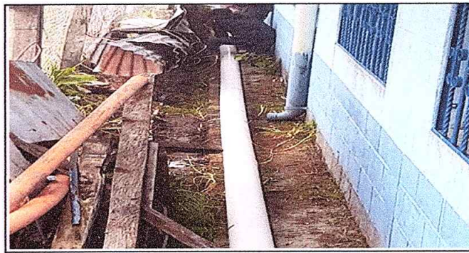
Foto 6: Sustitución de tubería de pvc de 4 pulgadas
