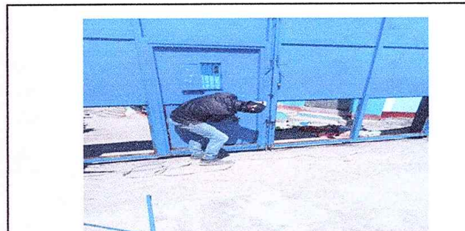
Foto 6: Mantenimiento de portón de metal
