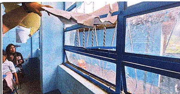
Foto 5: Sustrutucion de vidrios
