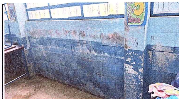
Foto 10: Pintura en muros interiores.
