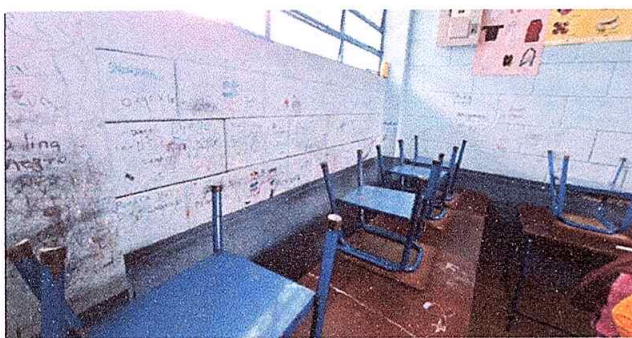
Foto 9: Pintura en muros interiores
