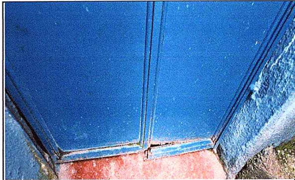
Foto 4: mantenimientos a puerta de metal
