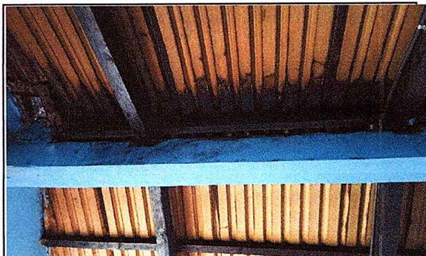
Foto 2: Sustrutucion de estructura de soporte de madera, por metal.
