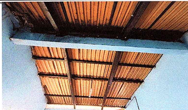
Foto 1: Sustrutucion de lamina troquelada
