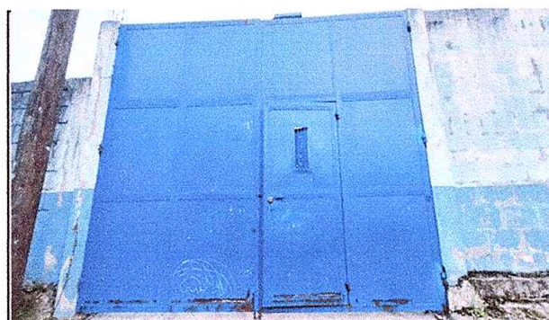
Foto 12: Mantenimieto de porton de metal.
