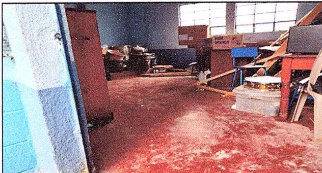
Foto 7: sustitucion de piso de granito.
