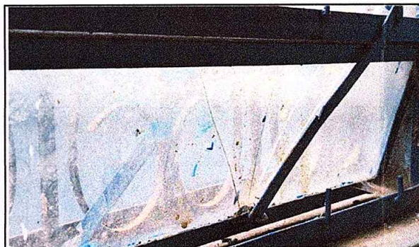
Foto 6: Sustrutucion de vidrios
