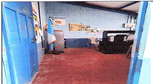
Foto 8: Ssutitucion de piso de granito.
