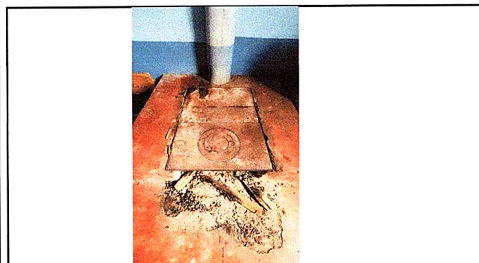
Foto 17: Sustrucción de estufa rural completa
