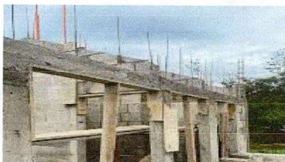
Foto 9: Canales y bajadas de agua pluvial: Colocación de canales PVC, codos, y mejoramiento de bajada de agua pluvial. (Despues de colocar la lamina troquelada se procedera a colocar los canales.)
