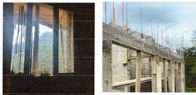
Foto 2: Ventanas: Fabricación y colocación de ventanas
