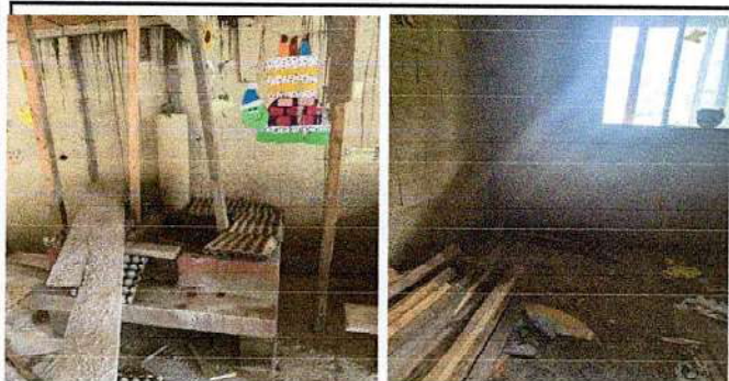
Foto 3: Mejoramiento de cocina (Mejoramiento de chimenea, pilas de dos lavaderos y sustitución de estufa rural)
