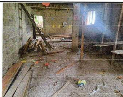
Foto 6: Piso: Sustitución de piso de torta de cemento por piso liso
