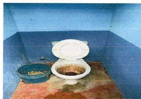
Foto 10: Reparación de baño: Sustitución inodoro
