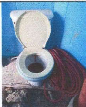
Foto 3: mejoramiento de inodoro
