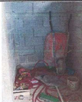
Foto 4: colocación y mejoramiento de baños
