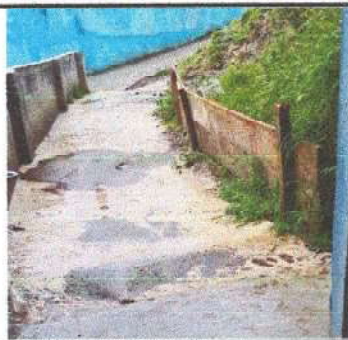
Foto 6: sustitución de torta de cemento por torta de cemento
