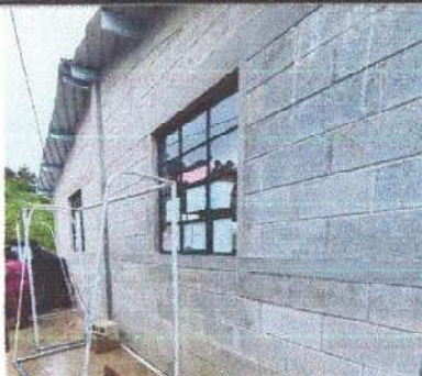
Foto 2: muro exterior donde se le aplicara la pintura
