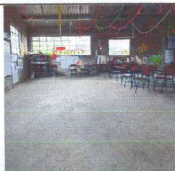
Foto 5: espacio del aula 2 para colocar piso granito
