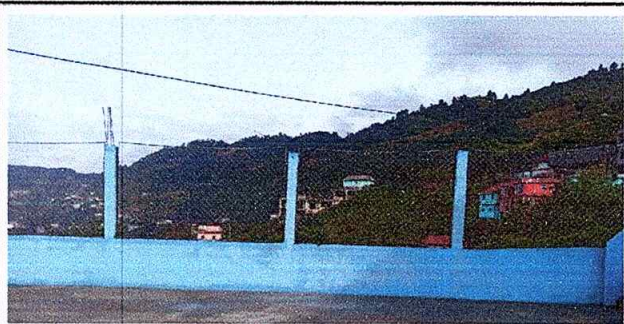
Foto 5: SUSTITUCION DE MALLA GALVANIZADA POR MALLA GALVANIZADA
