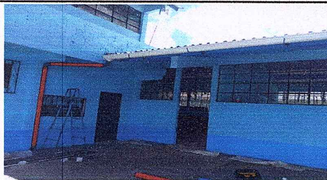
Foto 3: MEJORAMIENTO CON CANAL DE PVC + BAJADA DE AGUA PLUVIAL
