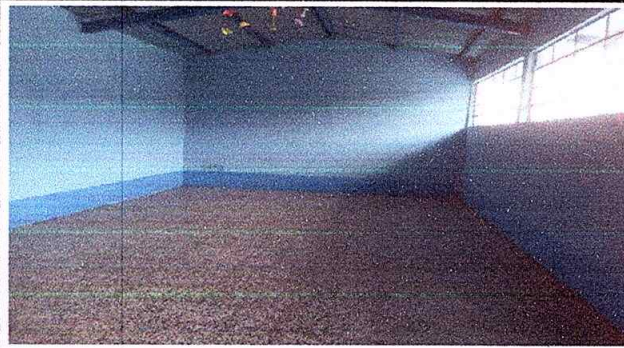
Foto 1: SUSTITUCION DE PISO DE CEMENTO LIQUIDO POR PISO DE GRANITO
