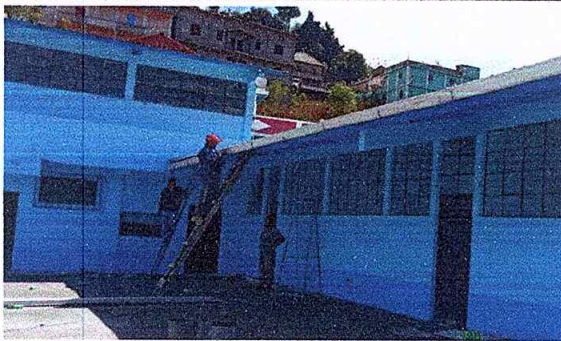
Foto 3: MEJORAMIENTO CON CANAL DE PVC + BAJADA DE AGUA PLUVIAL
