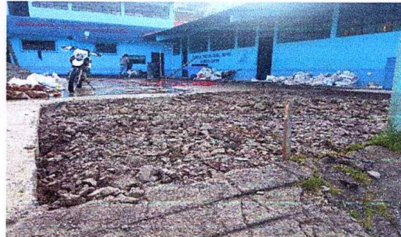
Foto 2: SUSTITUCION DE TORTA DE CEMENTO CONCRETO POR TORTA DE CEMENTO
