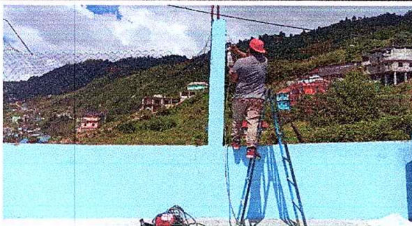
Foto 5: SUSTITUCION DE MALLA GALVANIZADA POR MALLA GALVANIZADA
