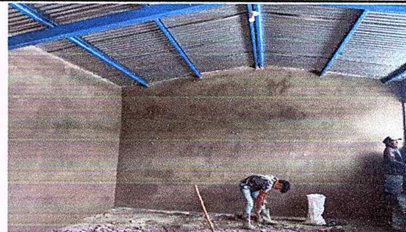
Foto 6: REPELLO Y CERNIDO DE PAREDES
