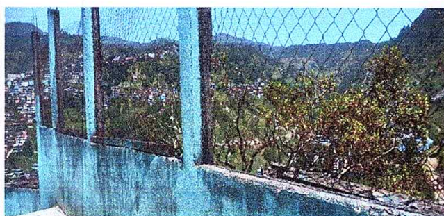
Foto 5: SUSTITUCION DE MALLA GALVANIZADA POR MALLA GALVANIZADA
