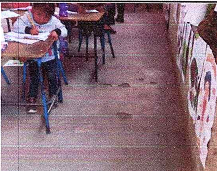
Foto 1: SUSTITUCION DE PISO DE CEMENTO LIQUIDO POR PISO DE GRANITO
