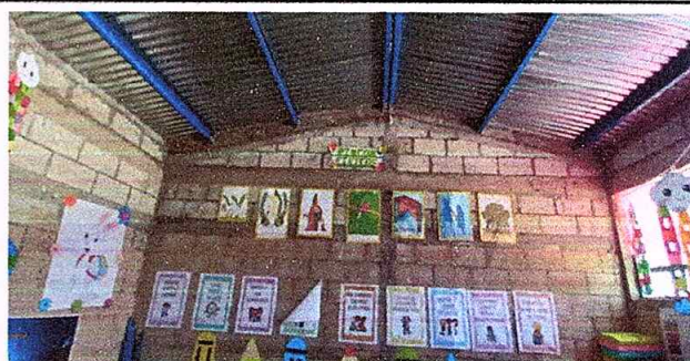
Foto 6: REPELLO Y CERNIDO DE PAREDES
