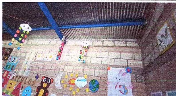
Foto 4: PINTURA EN MUROS EXTERIORES E INTERIORES
