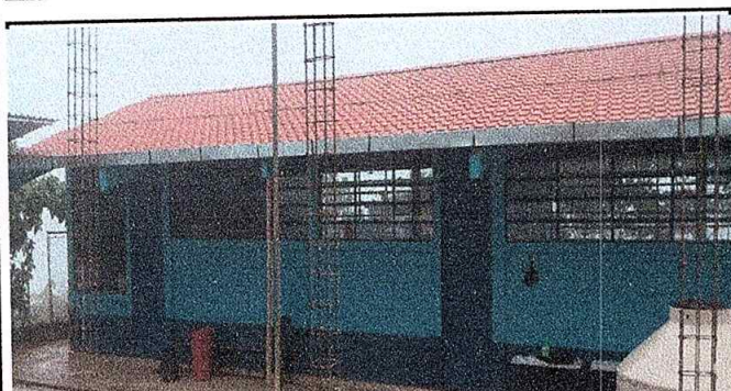
FOTO 3: SUSTITUCION DE CANAL + BAJADA DE AGUA PLUVIAL DE METAL POR TUBO PVC CANALES 3 PULGADAS
