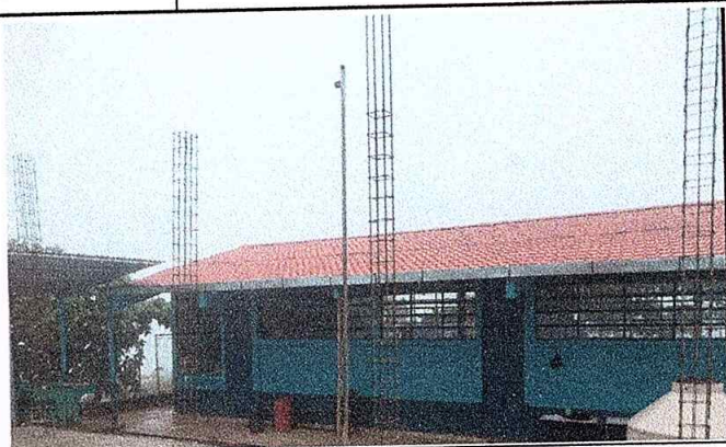
FOTO 2.SUSTITUCION DE LAMINA, POR LAMINA TROQUELADA ALUZINC CALIBRE 26
