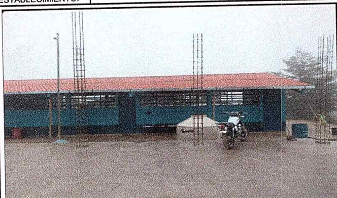
Foto1: SUSTITUCION DE LAMINA A LAMINA TROQUELADA
