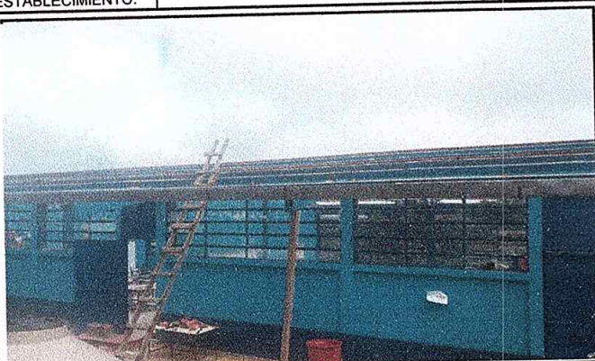
Foto1: SUSTITUCION DE LAMINA A LAMINA TROQUELADA
