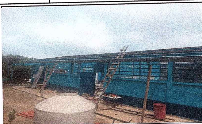
FOTO 2.SUSTITUCION DE LAMINA, POR LAMINA TROQUELADA ALUZINC CALIBRE 26
