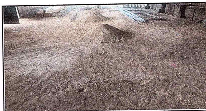
Foto 6: MEJORAMIENTO CON PISO DE TORTA DE CEMENTO EN AREA DEL SALON DE LA ESCUELA
