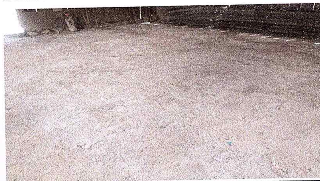
Foto 4: MEJORAMIENTO CON PISO DE TORTA DE CEMENTO EN AREA DEL SALON DE LA ESCUELA
