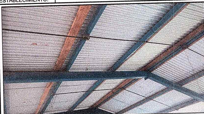
Foto1: SUSTITUCION DE LAMINA A LAMINA TROQUELADA
