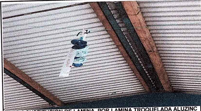
FOTO 2.SUSTITUCION DE LAMINA, POR LAMINA TROQUELADA ALUZING CALIBRE 26
