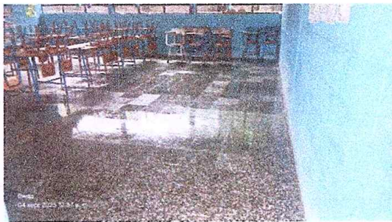
Foto 6: Pisos de granito en el aula 2 colocacion terminada
