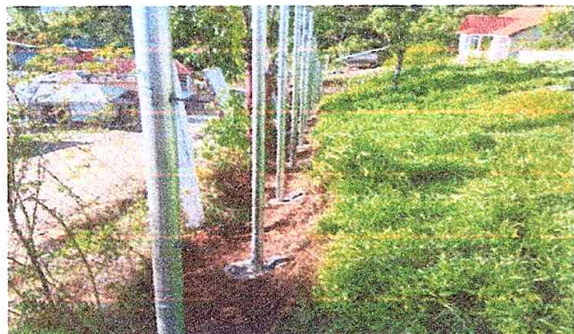
Foto 3: Sembrados de tubo hg galvanizadas para enmallado del perimetro
