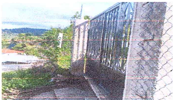
Foto 1: Sustrucción de portón de metal (2.50m de alto*4m de ancho)
