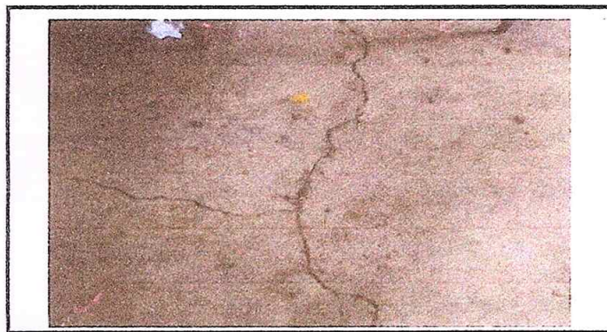
Foto 6: Sustitucion de piso de granito en el aula 2
