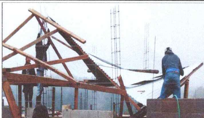
Foto 2: ESTRUCTURA DE TECHO
