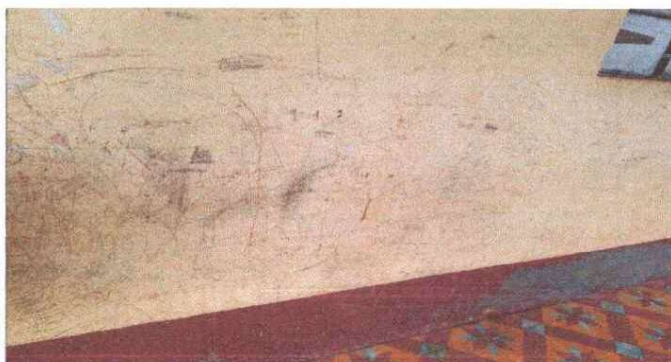
Foto 6: PINTURA EN MUROS EXTERIORES E INTERIORES
