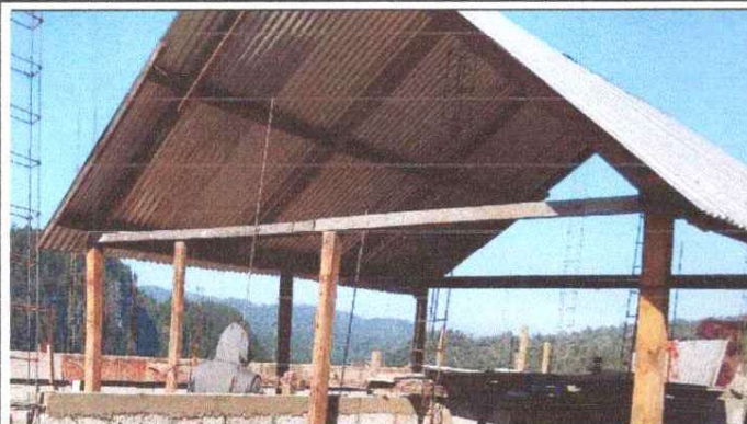
Foto 1: CUBIERTA DE LÁMINA
