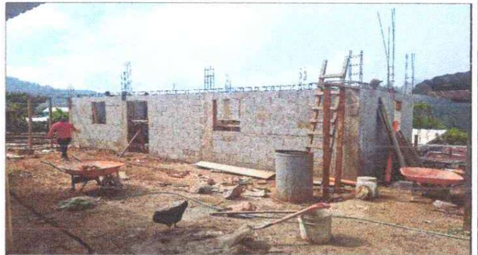
Foto 10: REPARACIÓN DE REPELO Y CERNIDO DE PAREDES
