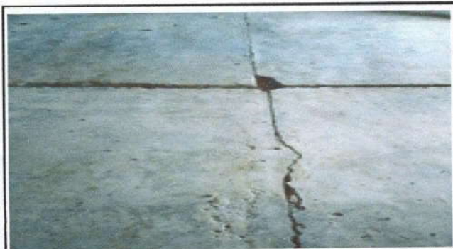
Foto 1. Sustitución de piso de granito
