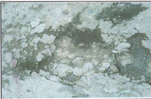
Foto 2: Sustitución de plancha de concreto de patio
