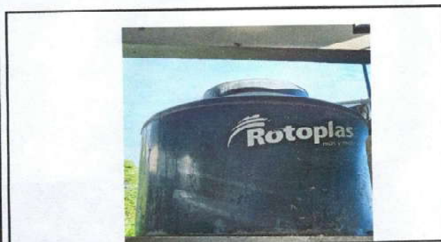
FOTO 1. Sustitución de depósito de agua
