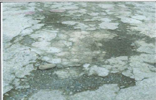
Foto1: Sustitución de plancha de concreto de patio
