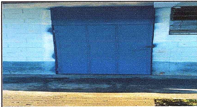
Foto 4: sustitucion de puerta de escuela en mal estado de metal de 2.75 cm. de alto x 100 cm. de ancho
