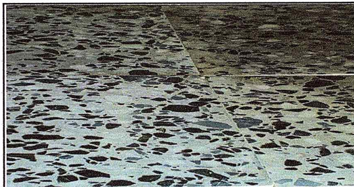
Foto 6: Mejoramiento con piso de torta de concreto en cocina
