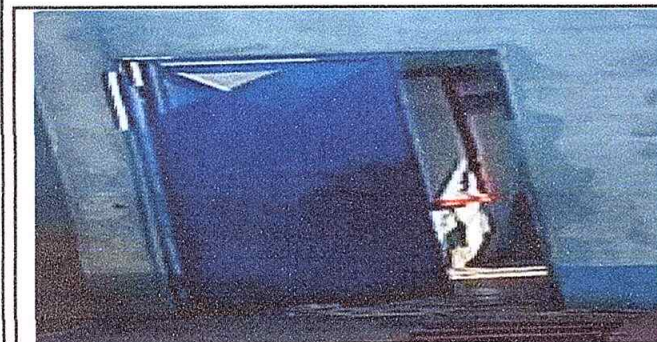
Foto 5: Sustitución de puerta de madera a metal de 2.5 mts. de alto x 1.00 mt. de ancho
