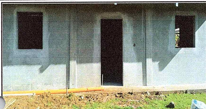
Foto. 7 mejoramiento de pared de cocina sin repello
