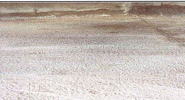
Foto 6: Mejoramiento con piso de torta de concreto en cocina
