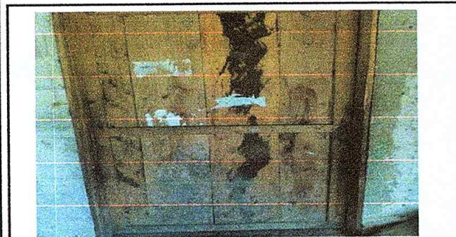
Foto 5: Sustrución de puerta de madera a metal de 2.5 mts. de alto x 1.00 mt. de ancho
