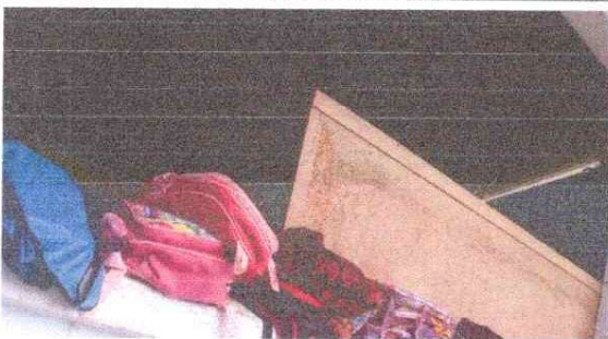
Foto 3: En la foto se obseva que las ventanas estan en malos estados por lo que se hace la sustitución de de ventanas de madera por metal, mas vidrio.
