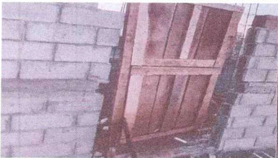
Foto 5: La puerta se obseva que esta hecho por madera, por lo que se cambiara por metal.
