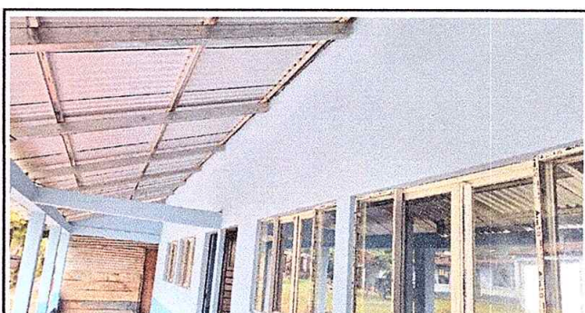
Foto 6: Sustitución de estructura de soporte de techo de madera ya deteriorada.
