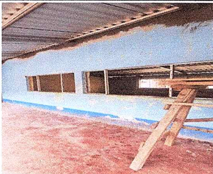
Foto 3: En esta imagen se puede ver la colocación de marcos de aluminio de las ventanas en frente de la escuela
