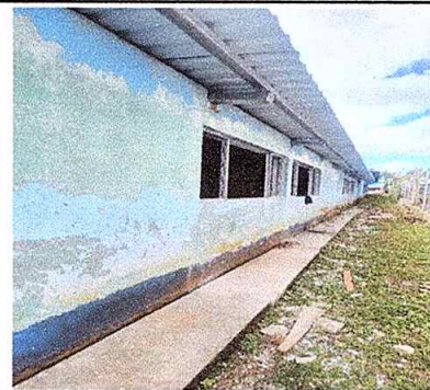
Foto 4: En esta fotografía se mira los marcos de las ventanas corredizas ya puestas en la parte de tras de la escuela.
