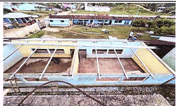
Foto 2: En esta fotografía se observa la colocación de vigas y costanera galvanizadas en el techo de la parte de atrás de la escuela.
