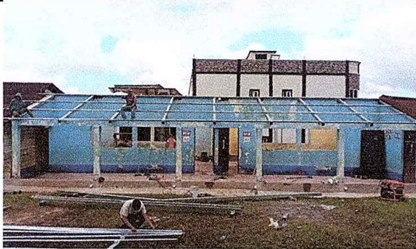
Foto 1: En esta imagen se observa la colocación de vigas y costaneras galvanizadas en la parte frontal de la escuela, posteriormente la colocación de láminas.
