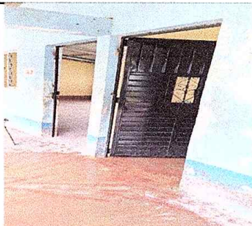
Foto 5: En esta imagen se ve la colocación de puertas de metal inoxidable
