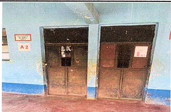
Foto 5: En esta imagen se ven puertas oxidadas y calcomidas de aulas que están en uso.
