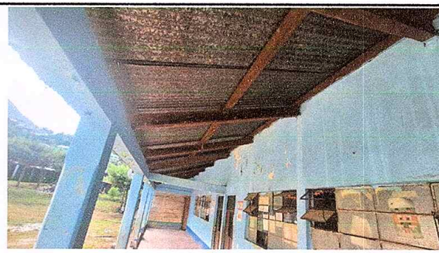
Foto 6: Sustitución de estructura de soporte de techo de madera ya deteriorada.
