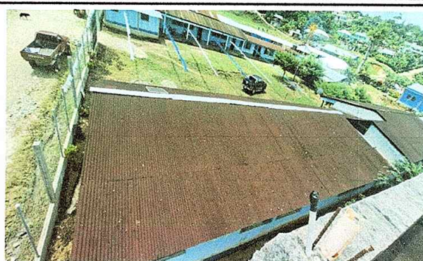
Foto 2: En esta fotografía se observa el techo trasero de las aulas con láminas de mal estado, oxidado.
